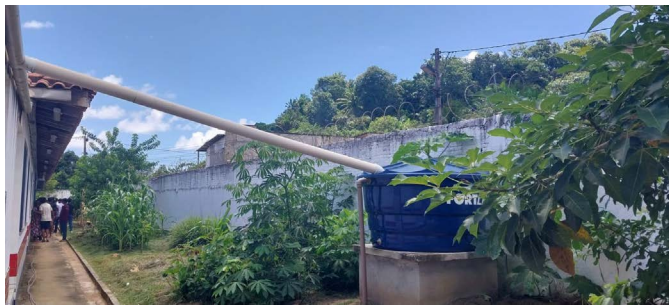
Figura 1 - Sistema de captação de água da chuva. Fonte: Ref. [10].
