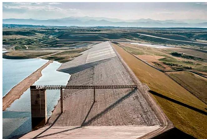
Figura 1 - Esquema da barragem de aterro (homogênea).<sup>1</sup>
